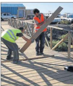
Mejoras. Obras en la pasarela, ayer.
