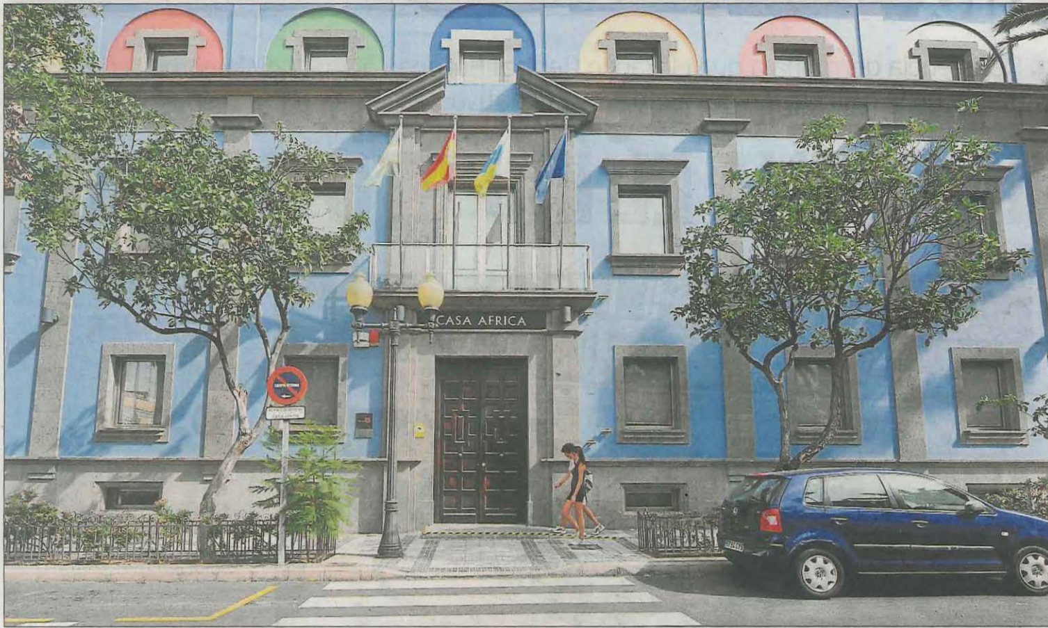
Cerrada a cal y canto. Imagen de la fachada de Casa África. Desde ayer (en la foto) permanece cerrada un mes para ahorrar costes.
