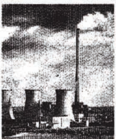
Una central térmica.
