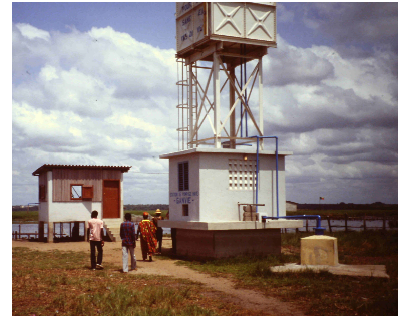
Depósito de agua
