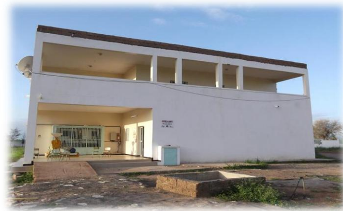
INSTALACIÓN FOTOVOLTAICA EN UN CENTRO DE SALUD
